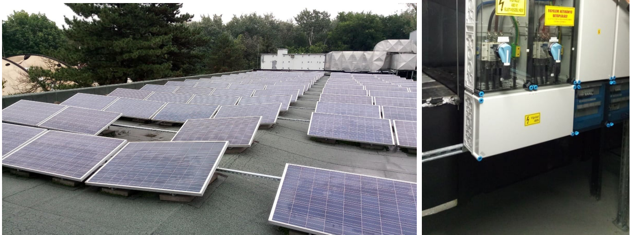
2. ábra. A B épület tetején lévő létesítmény egy része, valamint néhány kapcsolószekrény és inverter.
